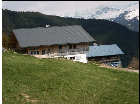
Photo 5 : Structure en bardage sur un soubassement en maçonnerie
